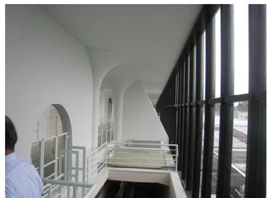
操作廊短手方向の控え壁
