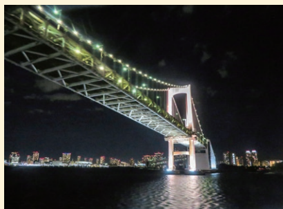
デッキより見るレインボーブリッジ。
